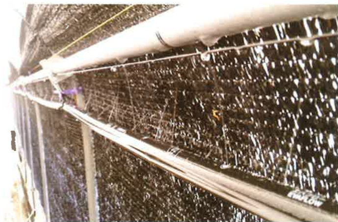
高温対策 ハウス側面に遮光幕を張り、地下水をエバーフローで放出。測定時の外気温は33℃でしたが、ハウス内は27℃に抑えられていた。
